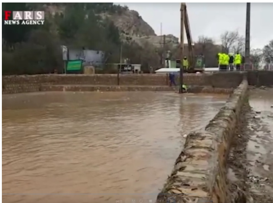
شکل ۲۵ تخلیه نشدن استخر در روز بعد سیل ۵-۱-۱۳۹۸ دروازه قرآن شیراز نشان از مسدود بودن دهانه لوله دارد
