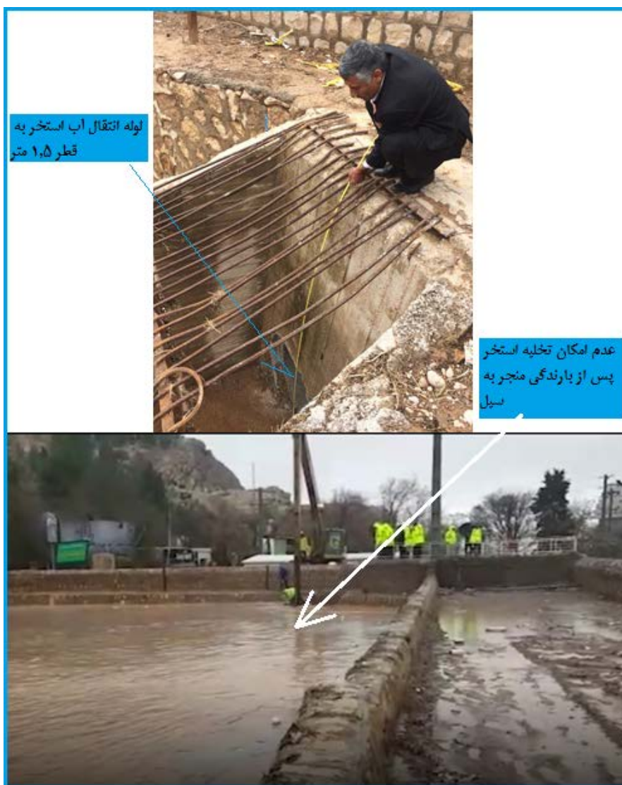
شکل ۴۵ لوله انتقال آب در کف استخر و پر بودن استخر تا روز بعد سیلاب
