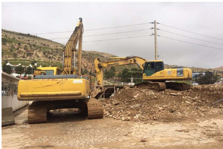
شکل ۲۶ حضور بیل های مکانیکی و برداشتن آشغال ها و بازکردن ورودی لوله در داخل استخر بعد از رخداد سیل (عکس از همکاران تهیه کننده این گزارش)
