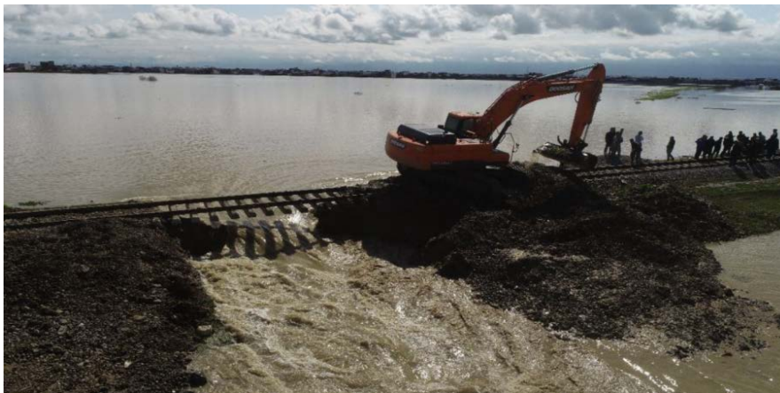
شکل ۳-۷ تسریع تخلیه آب با برش هایی در زیر ریل (تعداد دو برش حسب اعلام کارشناسان مقیم، با انفجار بوده است)
