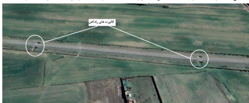
شکل ۳-۶ نمونه ای از کالورت ها که بوضوح از روی تصاویر google earth نیز قابل مشاهده است
