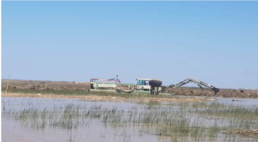
شکل ۱۱-۳ لایروبی خط ساحلی با هدف تسهیل ورود سیلاب به دریا
