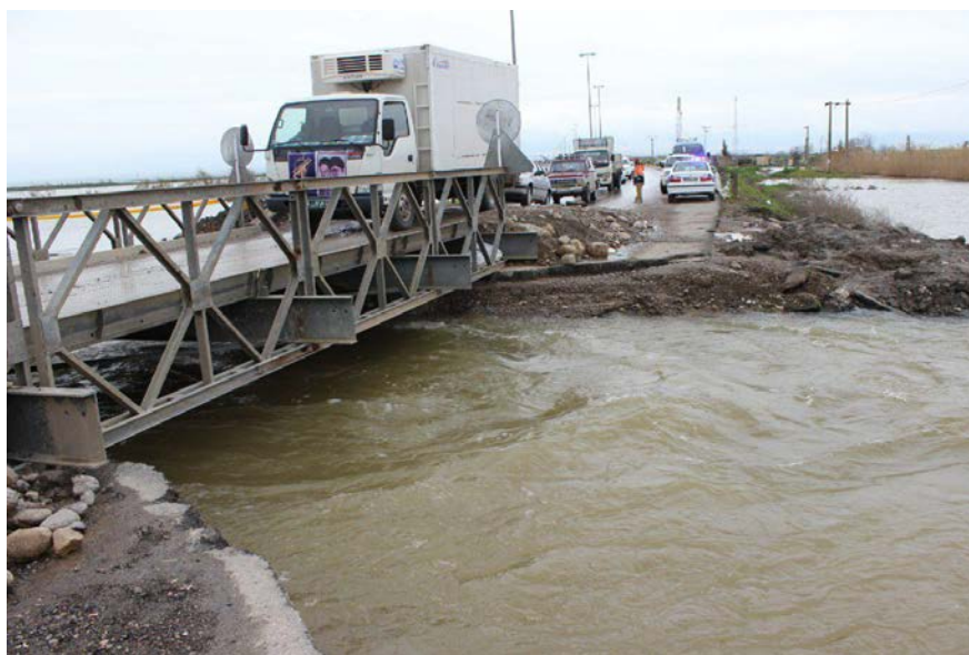
شکل ۳-۸ تسریع تخلیه آب با برش های جاده ای (این پل فلزی بعد از برش نصب شده است)
