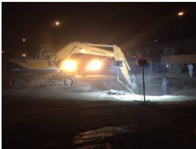
شکل ۴-۴- پرنمودن حفره ایجاد شده با مصالح سیمانی
