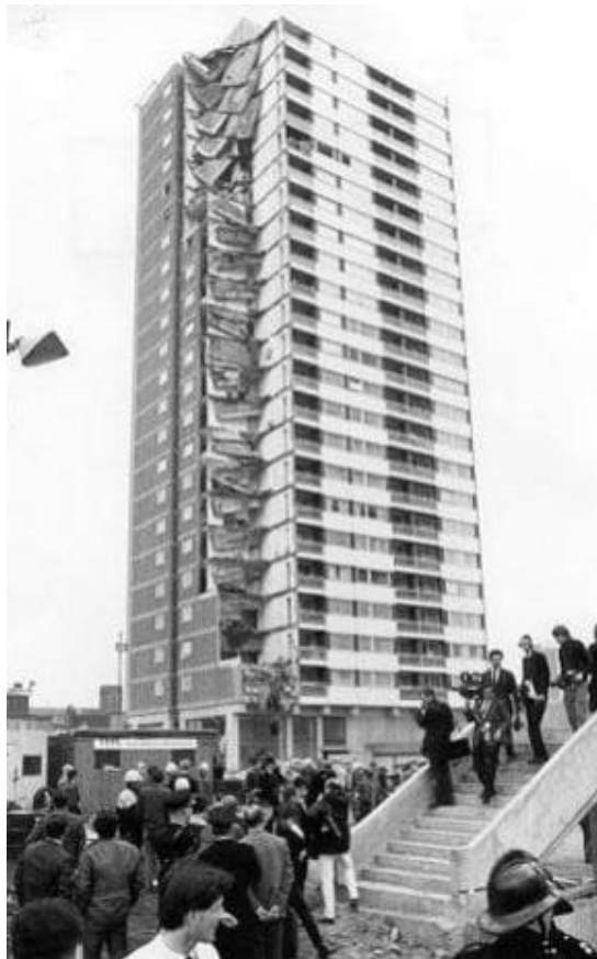
شکل ۷- ریزش بخشی از ساختمان رونان واقع در شرق لندن در اثر انفجار گاز و آتش سوزی
