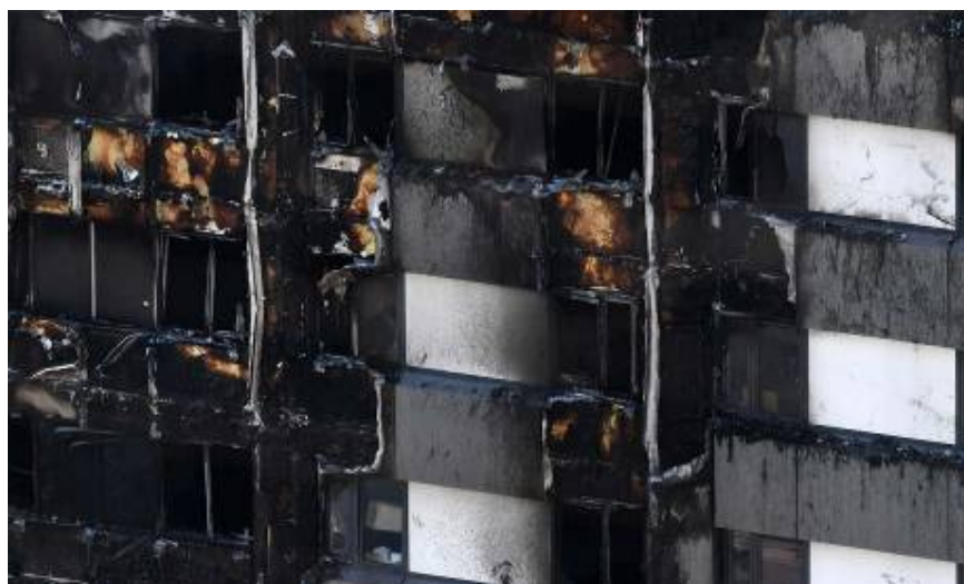
شکل ۱۱- نمای کامپوزیتی قابل اشتعال در برج گرنفل موثریت عامل تشدید و گسترش آتش بود.
