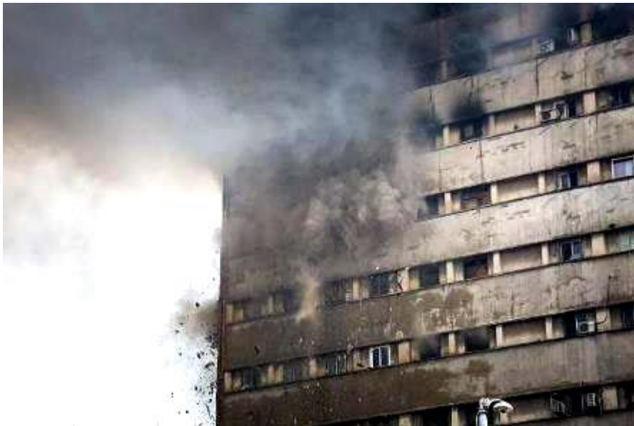
شکل ۴-۲۴- وقوع تخریب پیش رونده در ساختمان پلاسکو تحت اثر وزن طبقات فوقانی
