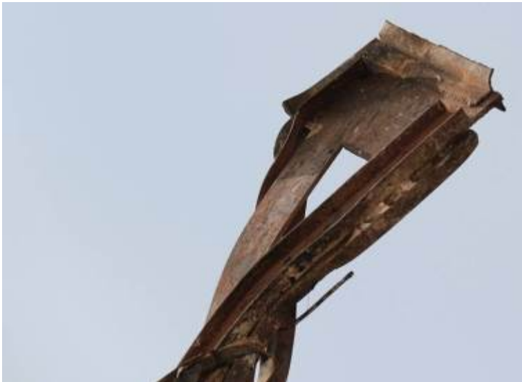
شکل ۴-۱۰- تصویری از انتهای تیر اصلی با فرم خرابایی و اتصال به کمک نبشی‌های فولادی دوبل
