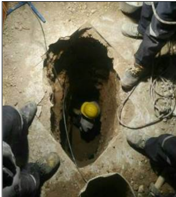
شکل ۶-۹- حفر تونل از یکی از مغازه‌های کناری در حال راه‌یافتن به زیرزمین ساختمان پلاسکو و دستیابی به بازماندگان احتمالی
