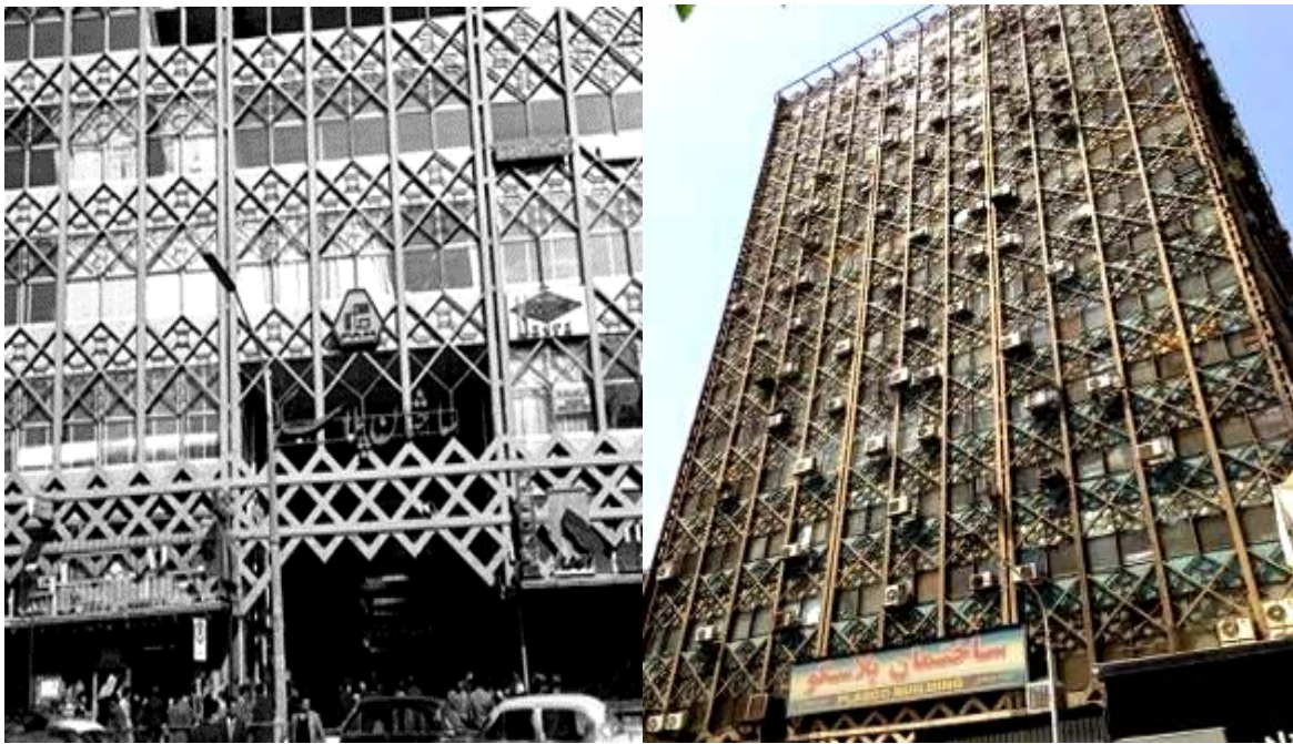
شکل ۴-۶- نمای فلزی در ضلع جنوبی ساختمان پلاسکو
