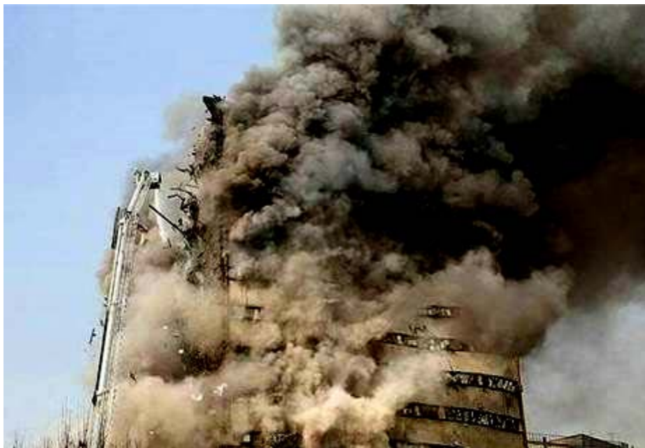
شکل ۴-۲۵- وقوع تخریب پیش رونده در ساختمان پلاسکو تحت اثر وزن طبقات فوقانی
