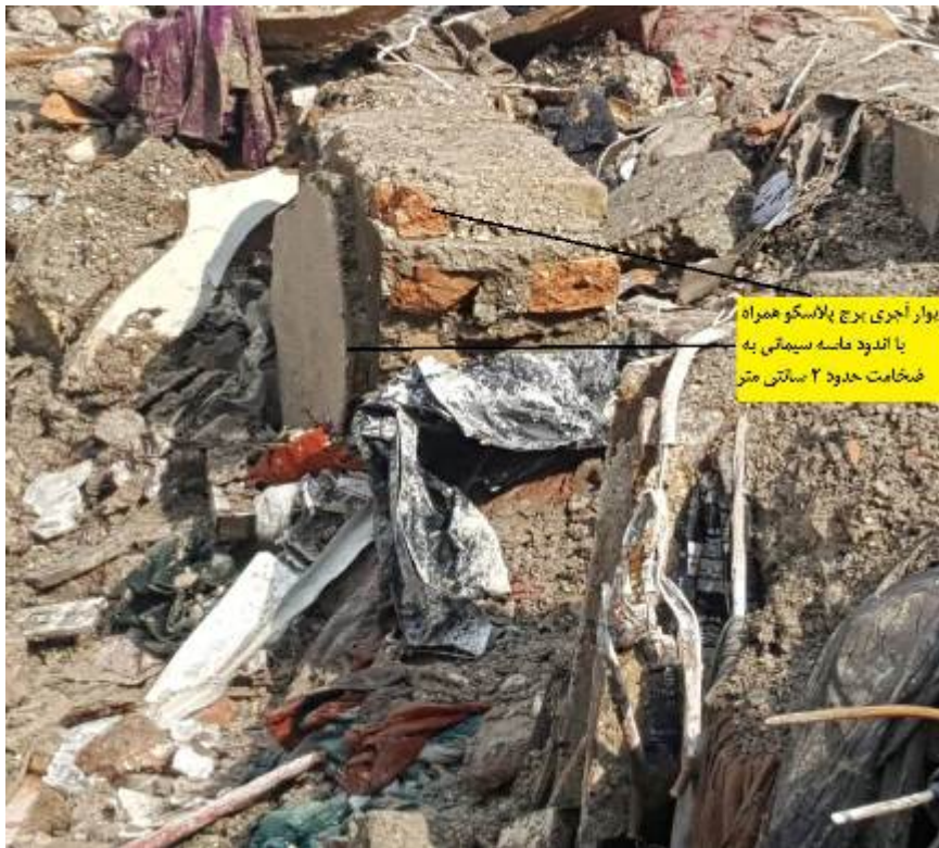
شکل ۴-۱۷- بخشی از دیوار آجری برج همراه با حدود ۲ سانتیمتر اندود ماسه سیمانی
