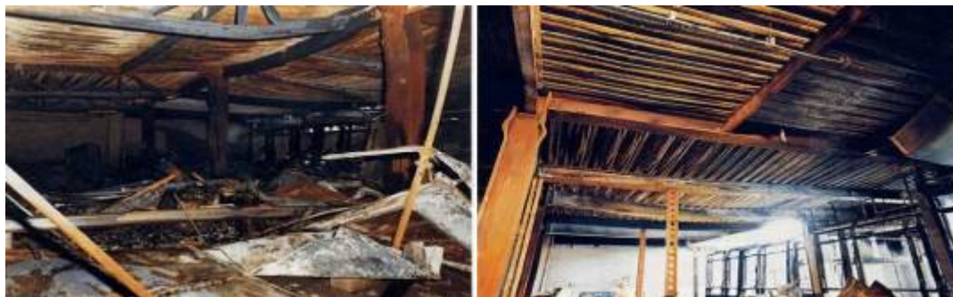
شکل ۴-۲۰- تغییر شکل تیرها و ستون‌های ساختمانی برودگیت در اثر آتش‌سوزی ۴/۵ ساعته
