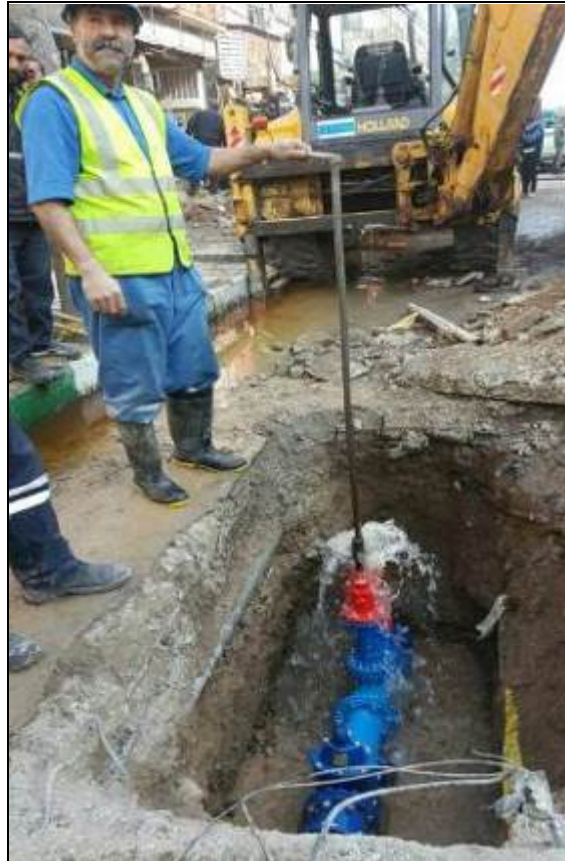
شکل ۶-۸- نصب شیرخط در خیابان جمهوری برای کمک به امدادسانی بهتر به حادثه پلاسکو.
