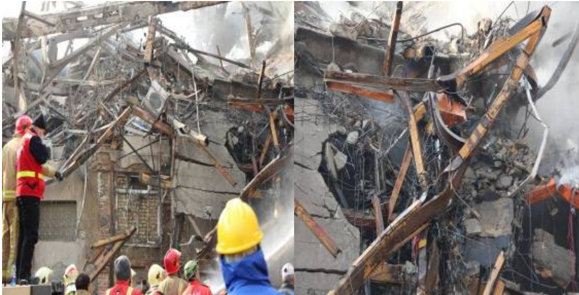
شکل ۴-۱۸- نمایی از سقف تخریب شده یکی از طبقات ساختمان پلاسکو با سیستم دال بتنی
