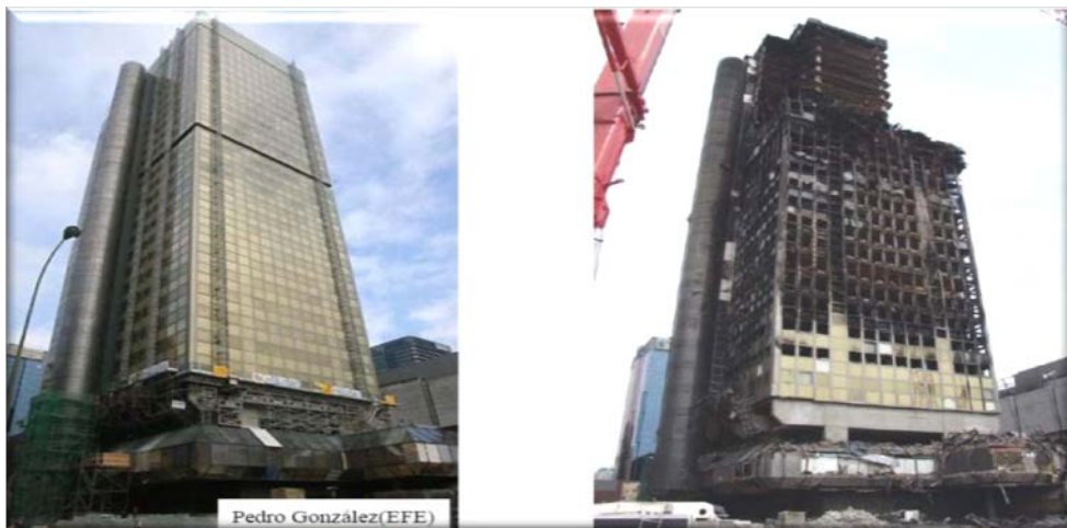
شکل ۴-۲۲- ساختمان وینزور قبل و بعد از آتش‌سوزی شامل خرابی پیش‌رونده طبقات ۲۱ تا ۳۲ (مادرید ۲۰۰۵)
