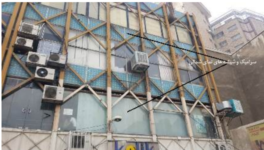
شکل ۴-۱۴- نمای شمالی پاساژ پلاسکو از شیشه و کاشی سنتی تشکیل می‌شود که در پشت کلاف‌بندی فولادی قرار دارد. این نما در آتش‌سوزی آسیب ندیده است
