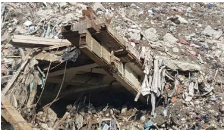
شکل ۴-۱۱- اتصال ستون‌های ساختمان با کلاف نما (ضلع جنوبی برج)
