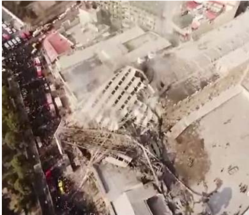
شکل ۴-۷- ریزش یکپارچه دیواره جانبی غربی بر روی آوارهای برج پلاسکو (بر گرفته از فیلم از ارتفاع)
