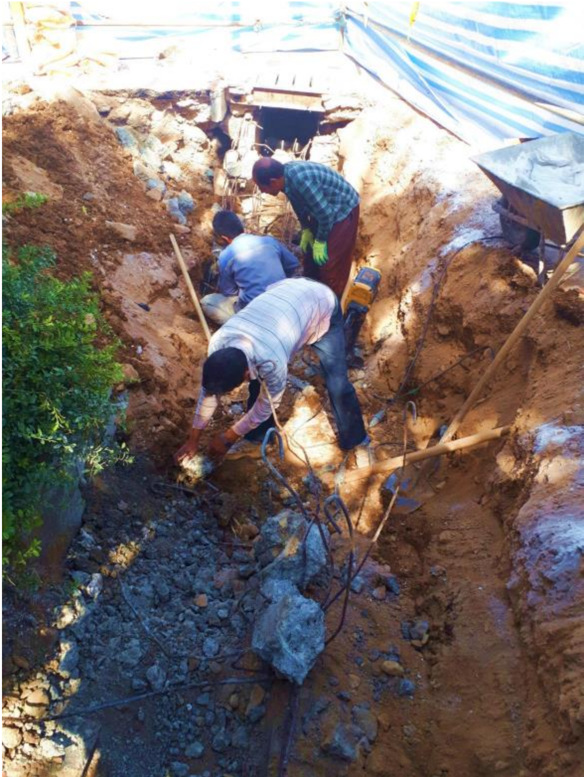
شکل ۶- خاک نرم و دستی موجود در پیرامون و زیر کانال انتقال آب
