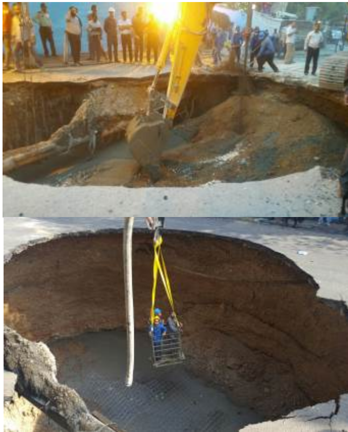
شکل ۴-۶- بتن ریزی داخل گود ایجاد شده توسط فرو ریزش
