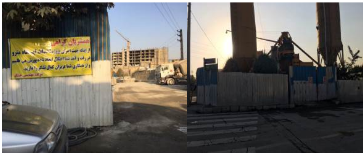
شکل ۴-۳- کارگاه‌های احداث خط مترو در منطقه شرکت مهندسی چیلکو
