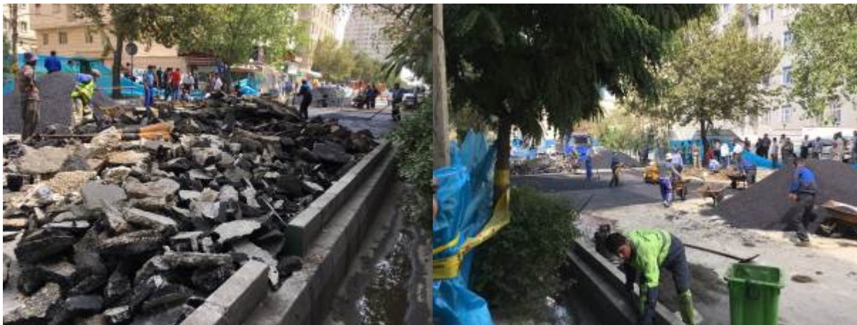
شکل ۴-۷- آسفالت کاری بلافاصله پس از بتن ریزی در محل حادثه
