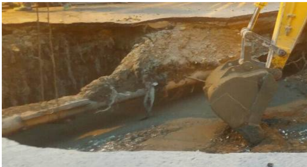
شکل ۴-۹- لوله‌های مربوط به آب و گاز در گود ایجاد شده محل حادثه
