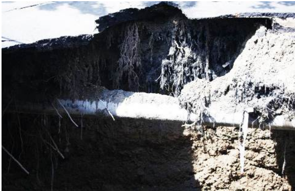
شکل ۶-۶- خط لوله انتقال آب در حفره ایجاد شده
