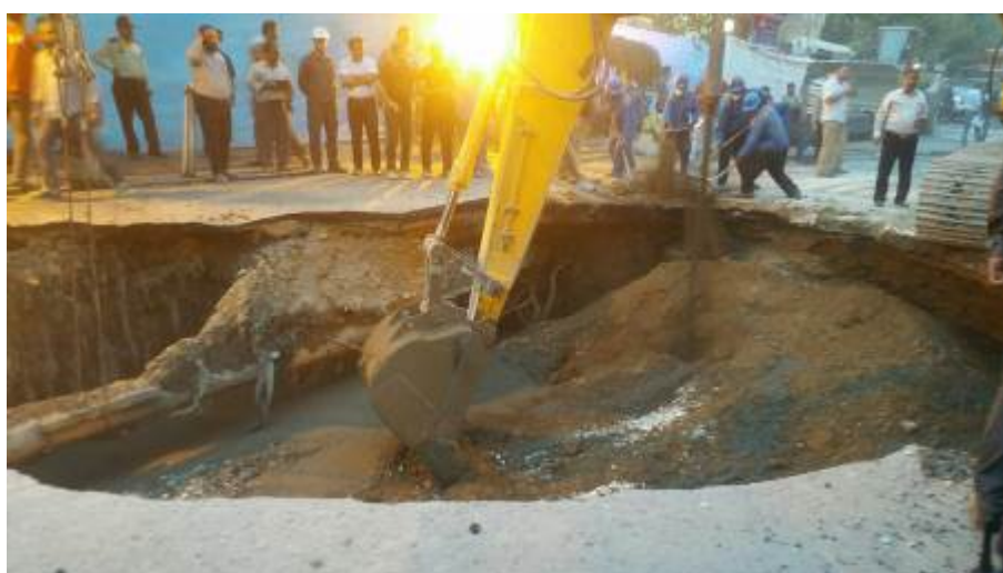
شکل ۸-۴- پر کردن حفره خیابان پیامبر توسط نیروهای امداد و نجات
